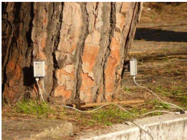
Inclinometri posti alla base del tronco posti in posizione ortogonale
