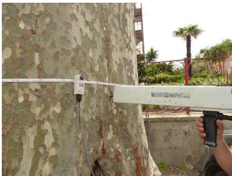
Analisi resistografiche al fusto in corrispondenza della ferita aperta al fusto
