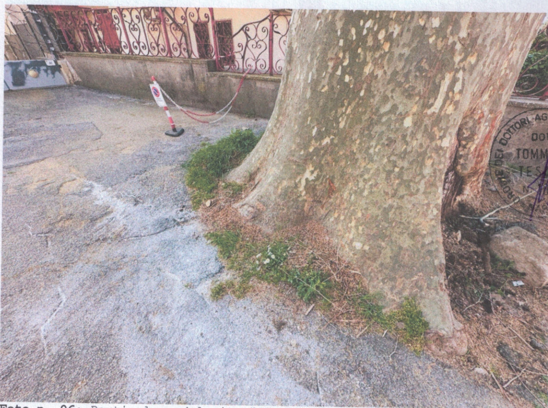
Foto n. 06: Particolare del sito "C" (lato est Piazza Stazione)
