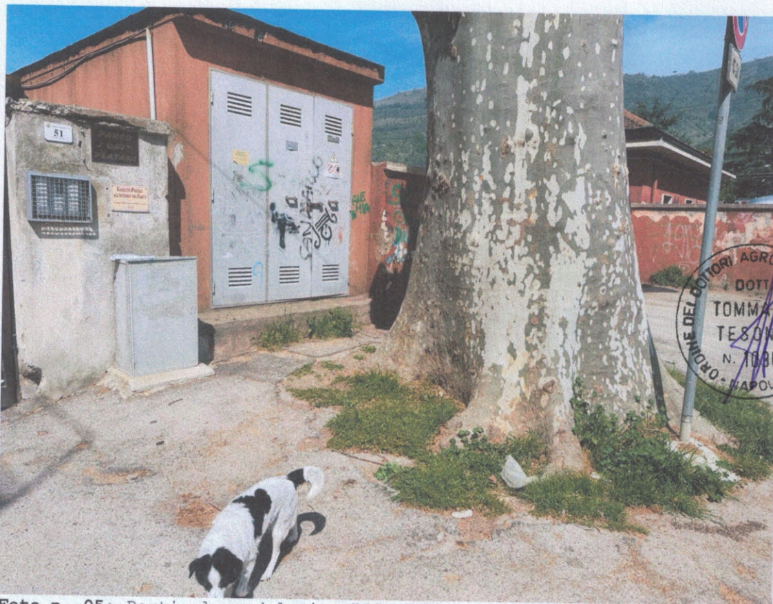
Foto n. 05: Particolare del sito "C" (lato ovest Piazza Stazione)
