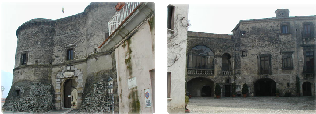
Fig.3/4- scorci interni ed esterni del castello ducale di Faicchio
