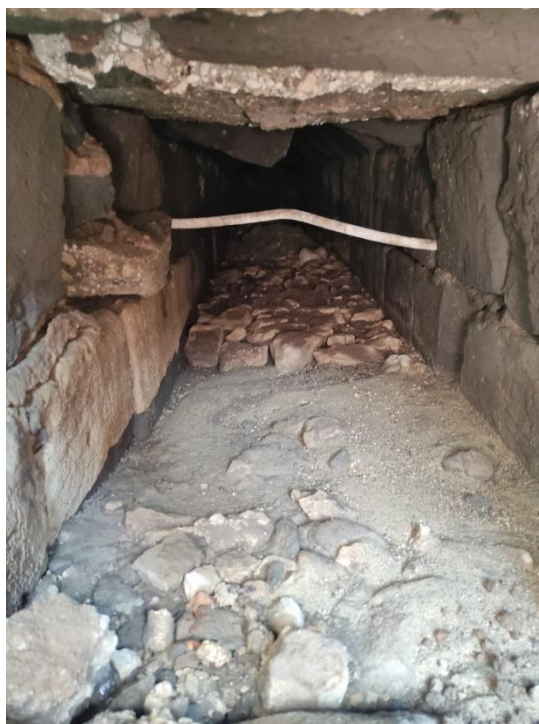
Fig. 50. Il canale idrico, sito 80.
