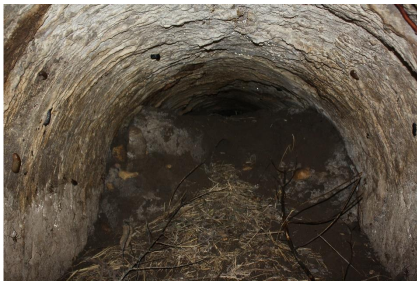
Fig. 66. La terza galleria.
