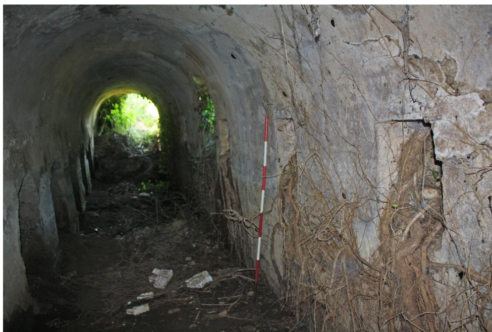
Fig. 64. La galleria meridionale: sulla destra sono visibili le finestrelle strombate.
