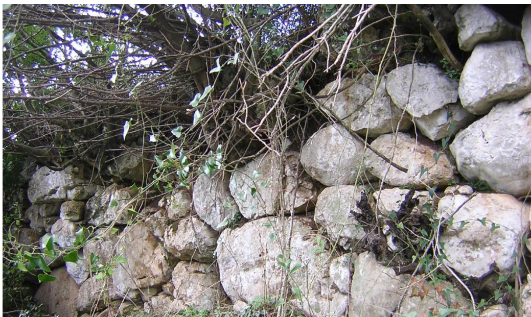
Fig. 52. Strutture in opera poligonale a delimitazione del Vallone San Michele.
