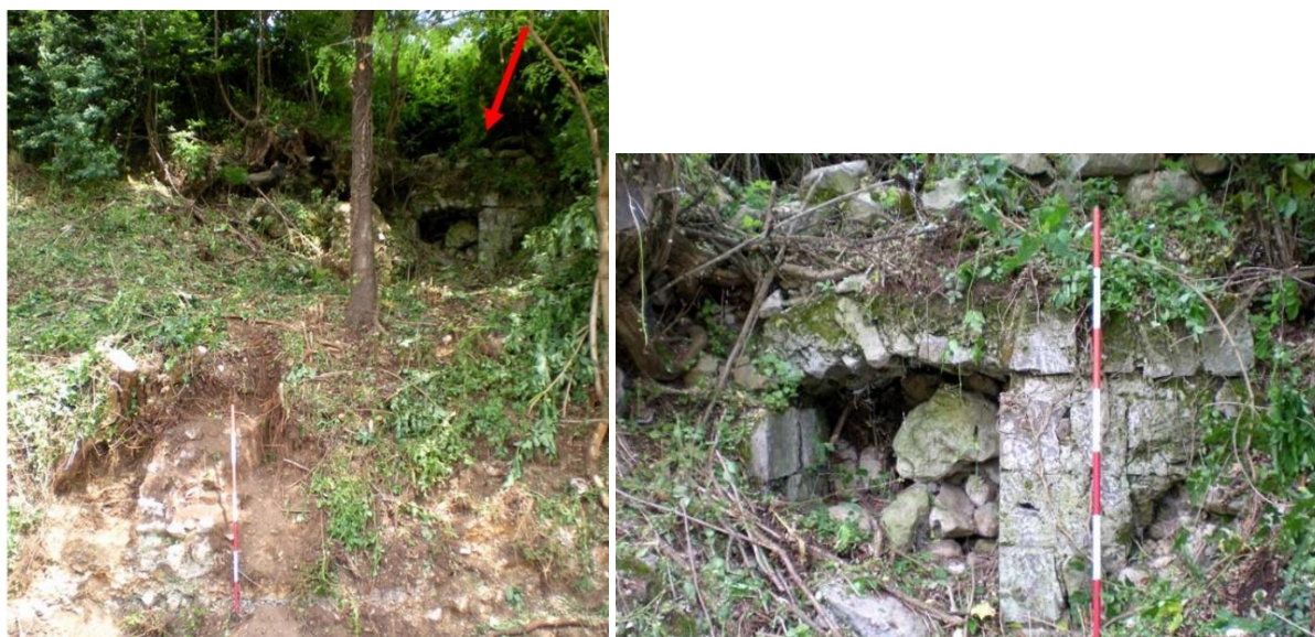
Fig. 38. Ubicazione dei resti della calcara sovrastanti i ruderi della chiesa medievale.
