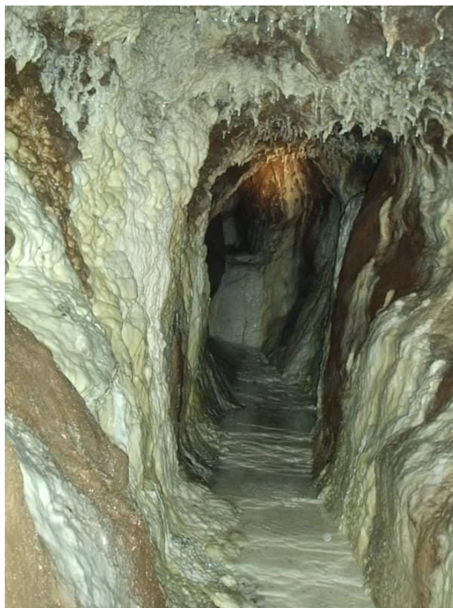
Fig. 32. Lo speco dell'acquedotto in loc. Fontanavecchia (cortesia di G. Stabile).
