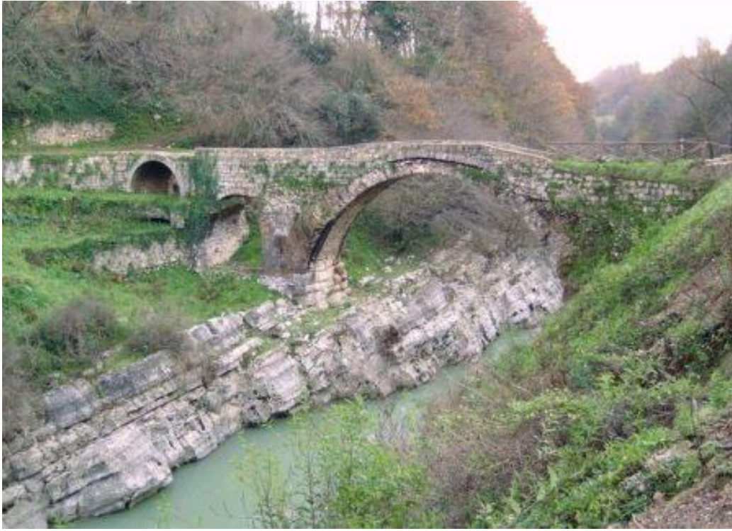
Fig. 29. Faicchio: il ponte cosiddetto di Fabio Massimo prima del restauro.
