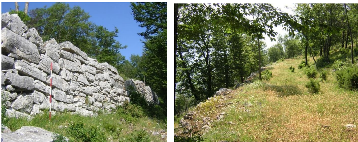
Fig. 94. Sulla sinistra le fortificazioni in opera poligonale, a destra il terrapieno contenuto dalla fortificazione.
